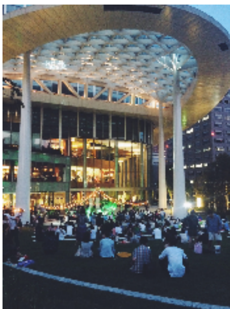
虎ノ門ヒルズ オーバル広場
